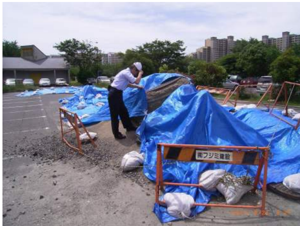
写真5 マンホールの抜け上がりを調べる 徳田兄
