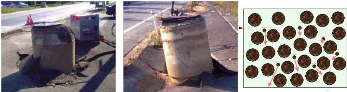
液状化現象によるマンホールの浮上（新潟県中越地震）
