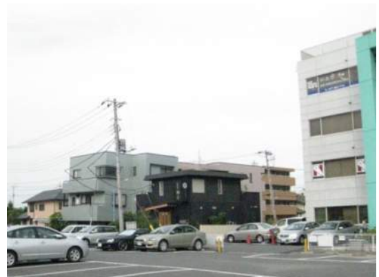
写真8 左側の灰色の3階建てビルが右手前 に傾斜している（志賀兄撮影）
