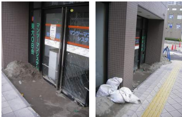
写真7 液状化によって沈下した鉄筋3階 建のビルディング（徳田兄撮影）
