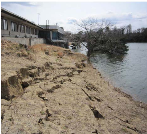
海岸地域の液状化による地すべり
